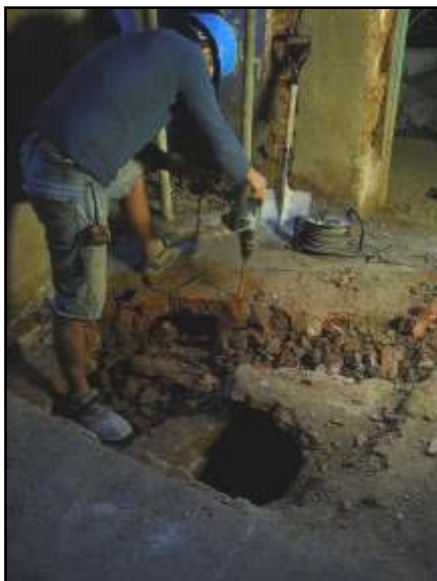
Foto 1. Treballs d'obertura del forat de l'ascensor
