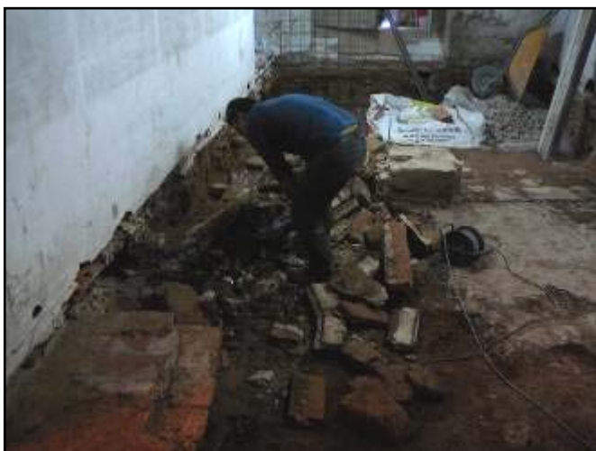
Foto 22. Procés de desmuntatge manual de la claveguera UE 1205 i 1220
