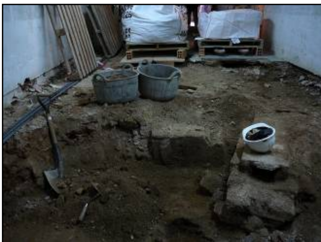
Foto 13. Continuació del rebaix manual a l'àmbit 3.2
