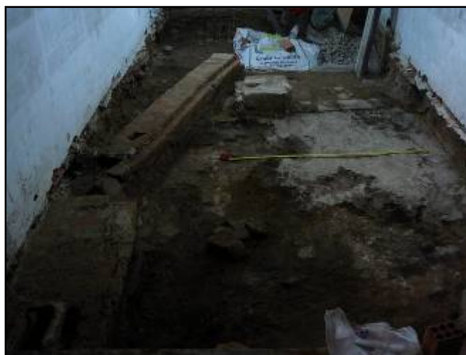
Foto 14. Final del rebaix de l'àmbit 3.2. Vista nord
