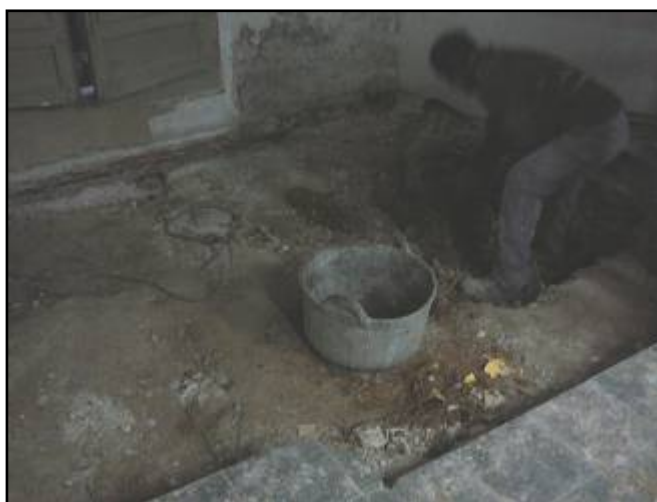
Foto 11. Inici del rebaix manual de l'àmbit 3
